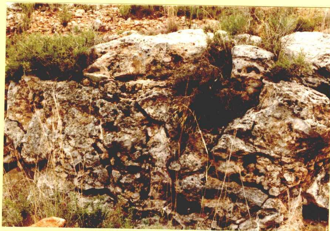
8.- Detalle de los depósitos travertínicos, muy compactados.
